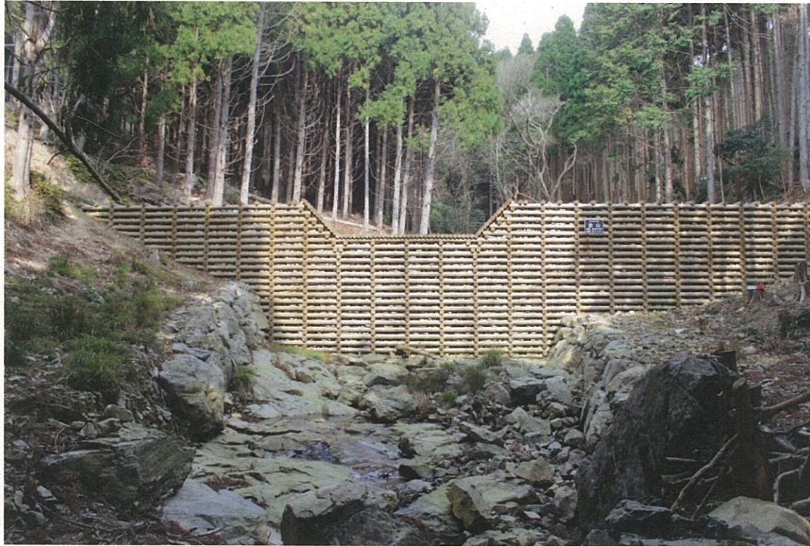
下流への土砂流出を防ぐ木製床固工(校倉式)
