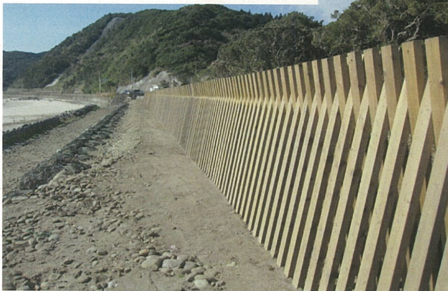
護岸や防風垣工(パネル型)の設置
