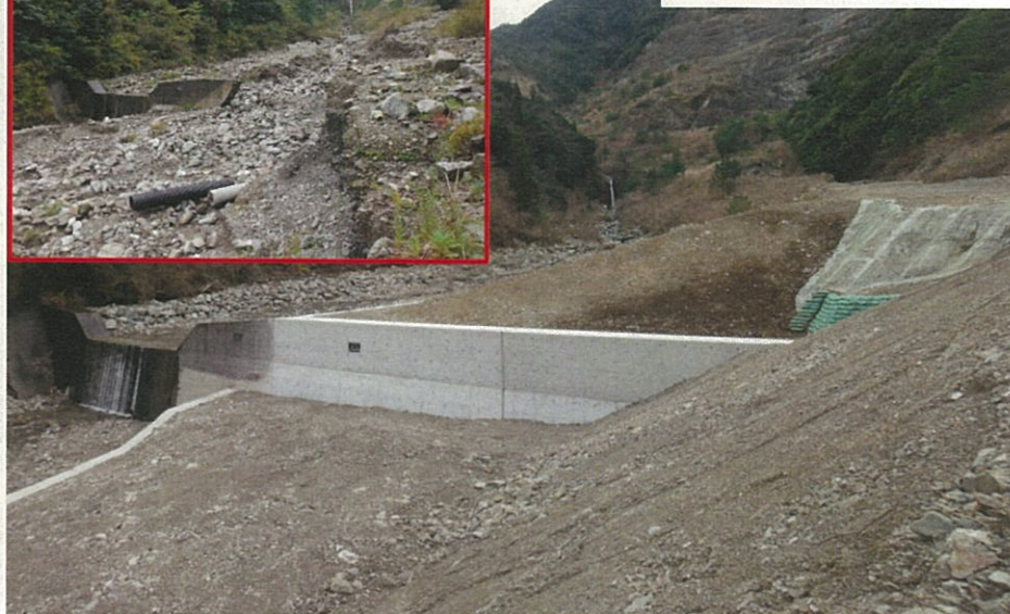
治山施設の復旧
