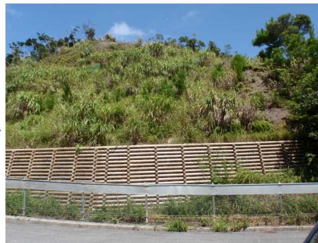
施工完了より3年後
