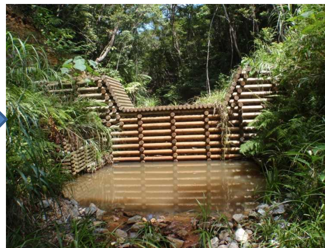
施工完了より2年後
