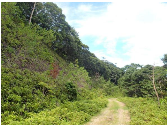
法面の枯れ個体と健全個体
