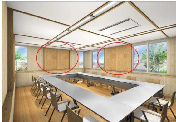
会議室棟内部にCLTを一部あらし(O印はCLT)
