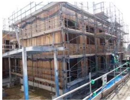
CLTを使って建設されたハウステンボス「変なホテル」(写真は建設中)
