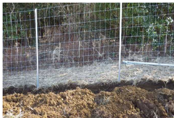
シカ被害対策の鋼製金網の設置
