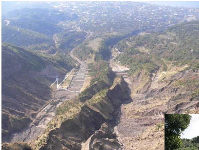
下流域を保全する治山ダム
