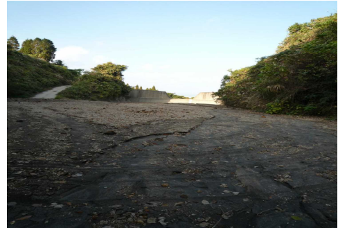
松浦川中流 待受けダム排土前
