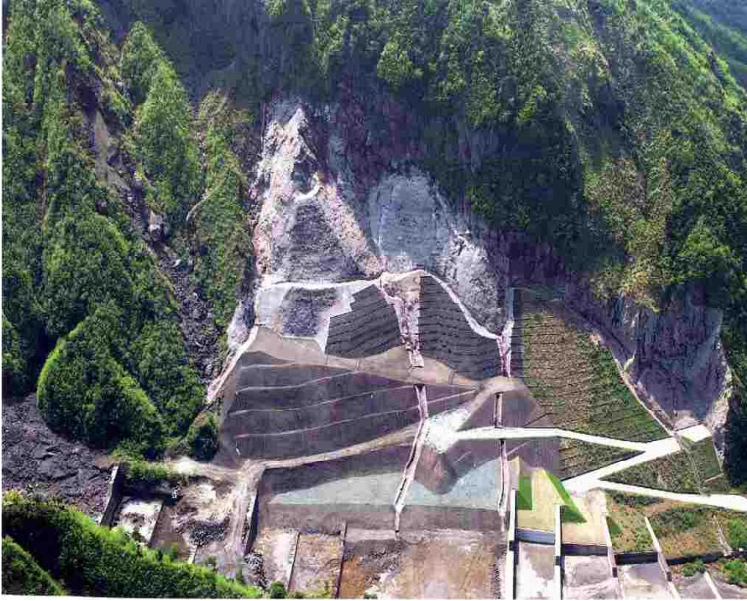
長谷川上流山腹工
