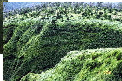
施工後3年経過（平成16年度）
