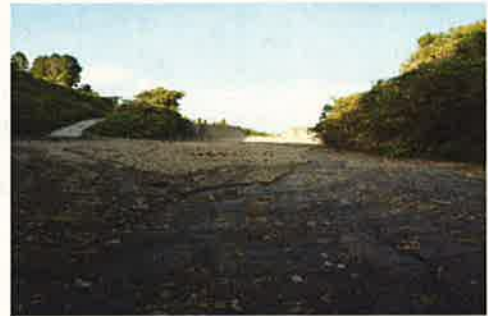
松浦川中流 待受けダム排土前
