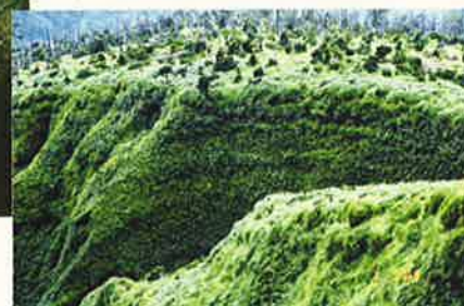
施工後3年経過（平成16年度）
