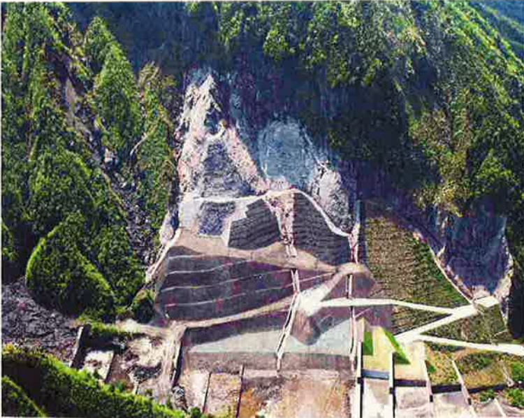
長谷川上流山腹工
