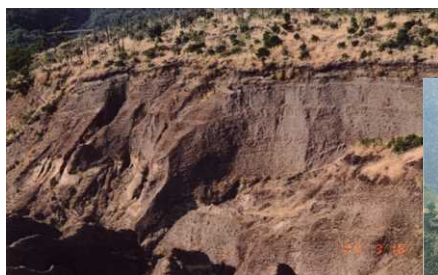
施工前（平成13年度）
