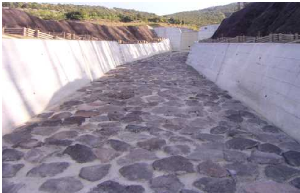
巨石を利用した流路工
