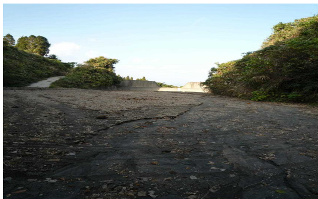
待受けダム排土前
