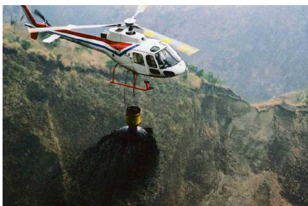
施工困難地で山腹緑化を促す航空実播工(桜島)
