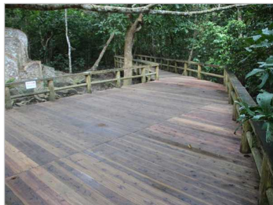
(写真 1-12) 観察木道デッキ(修繕後)
