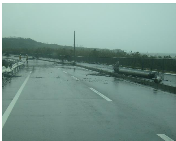
台風による被害（電柱の倒壊現場）
