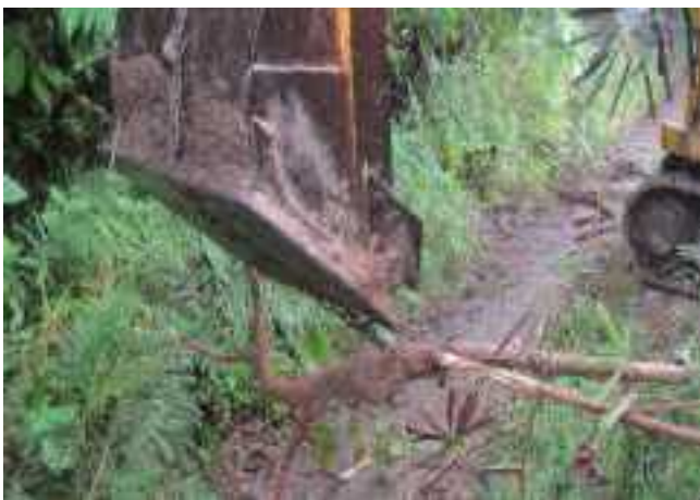
写真11 重機を使っでの抜き取り作業
