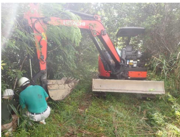
（写真12）重機を使って抜き取り作業
