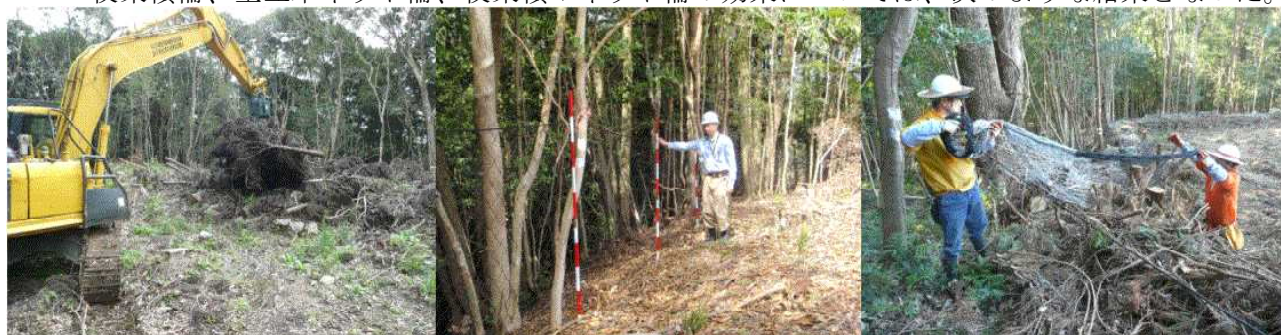
写真-9 低コスト防鹿柵(左からロングリーチグラップルによる枝条積、立木ネット柵、枝条積柵+ネット柵)
