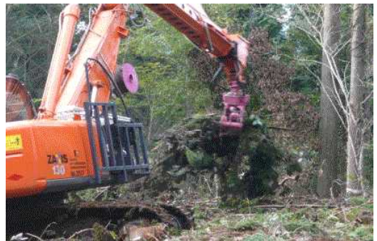
写真-2 ロングリーチグラップルによる地拵
