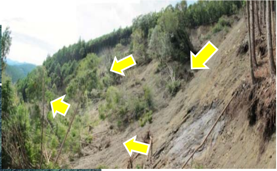
山腹崩壊地の状況
