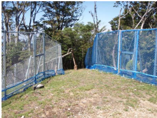
図-5 防護柵・防風ネットの設置
