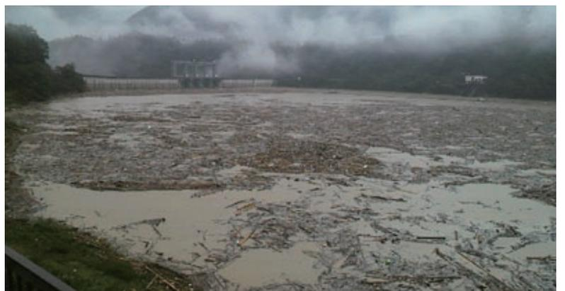
台風12号による流木の堆積状況（風屋ダム）
