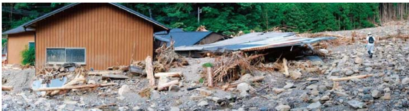
愛賀合区域 被害にあった人家の状況
