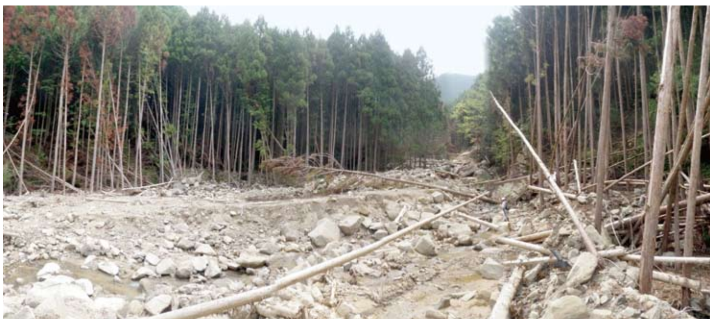
台風直後の被災状況(大量の土石で埋まった本田垣内区域の林道)
