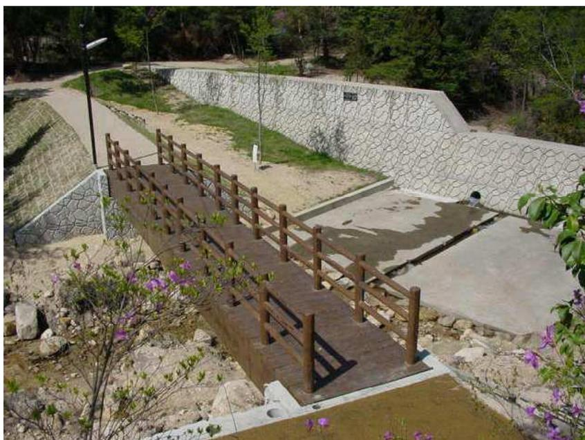
荒廃した溪流の溪床を安定させ、流れの乱流を防ぐとともに、土砂の流出を抑止することを目的としております。
