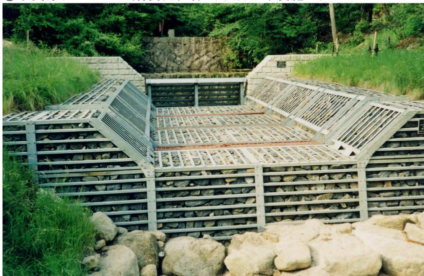
本工法は、鋼製堰堤と鋼製自在枠を併用し、更に木炭及び活性炭の浄化フィルターを装着することにより、流下する汚濁水や有機物を浄化するものです。
