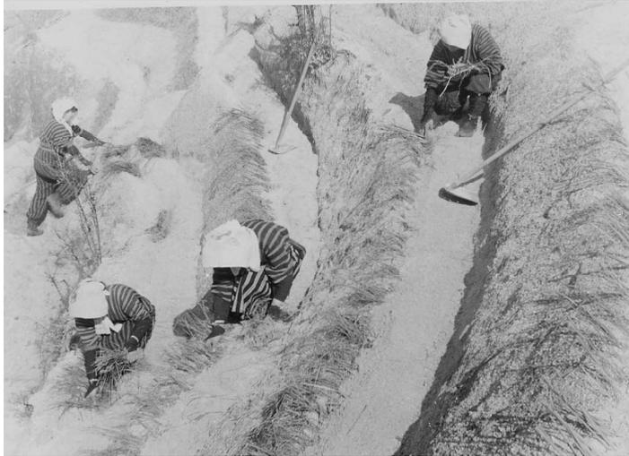
デ・レーケの山腹工法は、まず切り立った山を緩やかに切り直し、1～2m間隔で階段を切り付け、階段上の水平部分に稲藁を埋めて良く肥えた山土を客土として盛り、前面には山から取ってきた芝を張り付けて山土を押さえ、一定間隔に萱株を敷植え、客土へ過燐酸石灰を施肥し1年生の苗木（主な樹種：赤松・ヤシャブシ・山楡）を植栽するものです。
