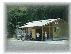
バイオマストイレ
