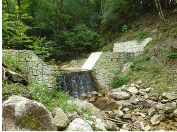
近年施工された谷止工
