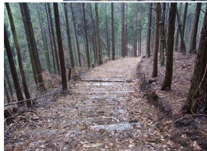
現場では軟弱地盤対策のため 丸太を敷並べている
