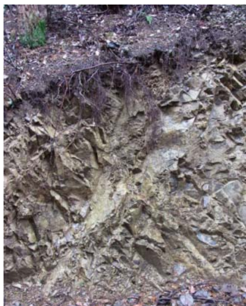
谷筋に向かうと砂岩の層が出てくる
