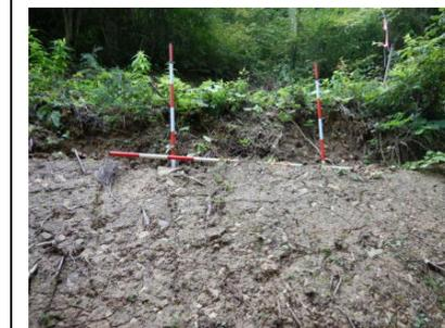
スギ生立木を中断切りして丸太土留めの支柱として使用。
