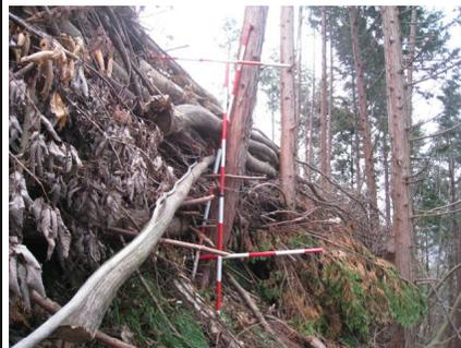
⑩ 丸太土留めの支柱としたヒノキ生立木の傾斜(ヒノキ支柱 D=21.8m H=15.8m)
