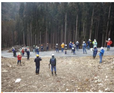
縦木平林業専用道の説明
