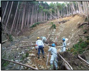
ヘリコプターによる全体調査及び崩壊箇所の現地踏査
