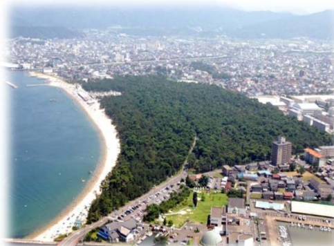
日本三大松原「気比の松原」海岸防災林整備（福井署・敦賀市）
