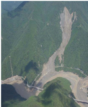
約17haの大規模崩壊地 (十津川村宇宮原区域・濁谷)
