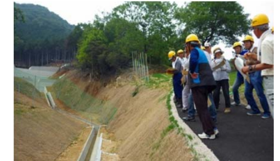
地元住民の方を対象とした復旧状況説明会の開催 (H28.5)
