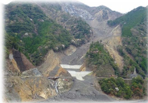
紀伊半島大水害からの復旧（奈良所・十津川村）
