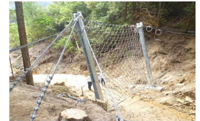
土石を一時的に受け止める仮設ネット工
