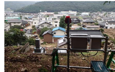
土石流センサーの設置状況
