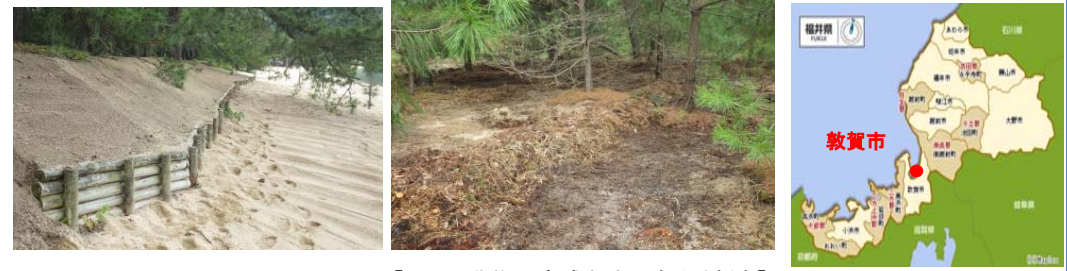
【マツの根を保護する養浜工】(H28,7) 【マツの稚樹の育成を助長する地掻き】(H28,9) あとかばやし
