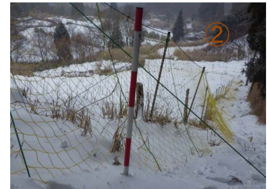
【斜め張り方式と多雪を踏まえた資材】 ・かみ切り防止のためのステンレスは入って無いが、燃本数が多いネットを使用 ・多雪地域で実績のある強度の高い支柱を使用
