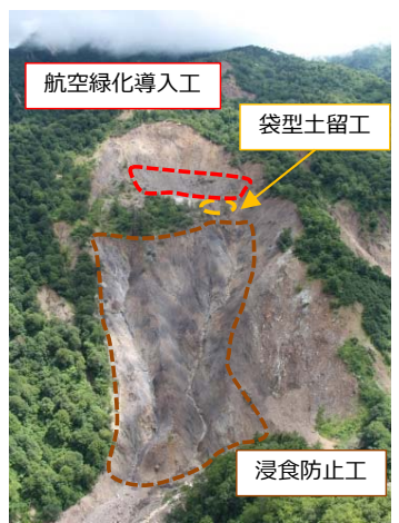
【完成状況】(H28,8)
