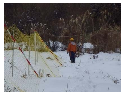
定期的に、支柱・ネットの損傷状況やシカの侵入状況等を点検・修理し、記録
