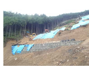
【山腹工の実施状況(八升前地区)】(H28,9)
