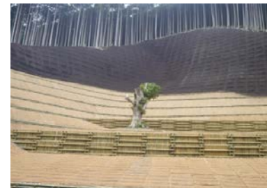
【山腹工に施工した丸太組土留工】
