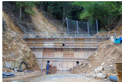
【高松山国有林の治山ダム施工状況】
