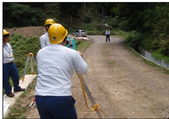
【現地での曲線確認の様子】
