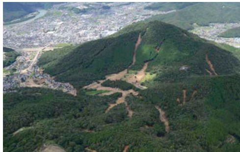
【高松山国有林の被災状況(遠景)】
