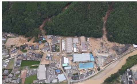
【高松山国有林の被災状況】
