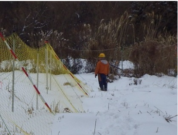
定期的に、支柱・ネットの損傷状況やシカの侵入状況等を点検・修理し、記録。
