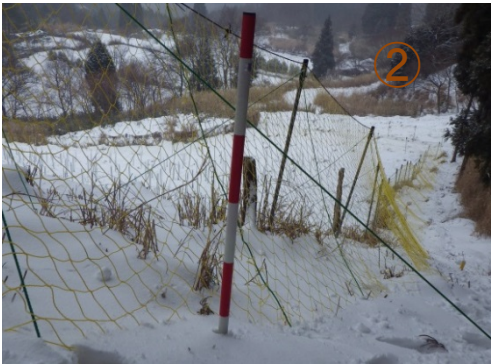
【斜め張り方式と多雪を踏まえた資材】 ・かみ切り防止のためのステンレスは入って無いが、撚本数が多いネットを使用 ・多雪地域で実績のある強度の高い支柱を使用
