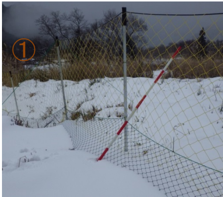
【従来の縦張り方式と多雪を踏まえた資材】 ・かみ切り防止のためのステンレスが入った撚本数が多い一般的なネットを使用 ・多雪地域で実績のある強度の高い支柱を使用
