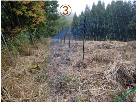
【斜め張り方式と資材】 ・かみ切り防止のためのステンレスが無く、撚本数も少ない安価なネットを使用 ・積雪のすべり加重を面で受け止めない構造のため、これに対応する安価な支柱を使用
