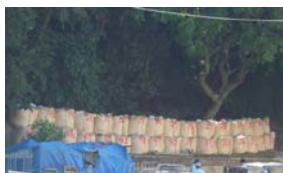
【大型土のうの設置状況】
