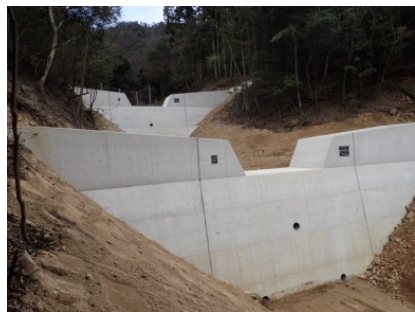
【高松山国有林の治山ダム施工状況】
