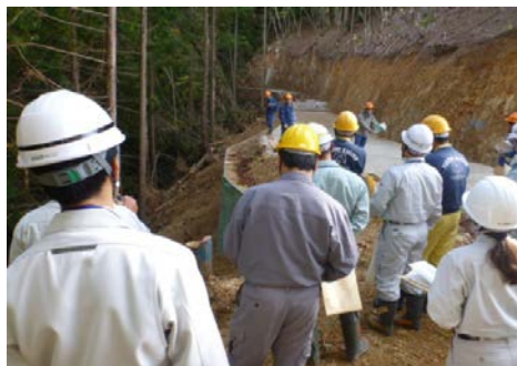
【林業専用道】(綾部市・古屋国有林)
