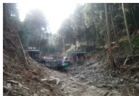
【強靱ワイヤーネット工施工状況】
