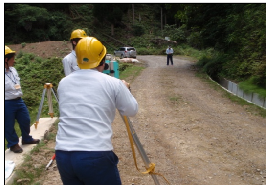
【現地での曲線確認の様子】
