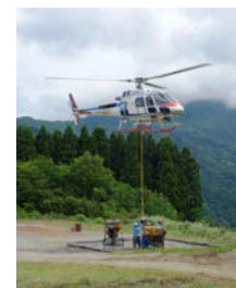
【凝固剤運搬の様子】
