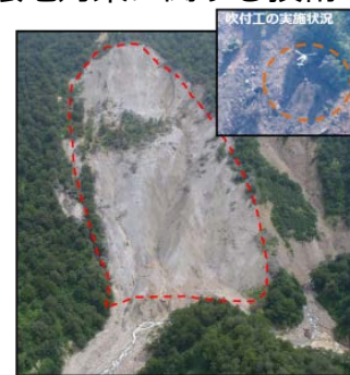
【工事完了後の様子】
