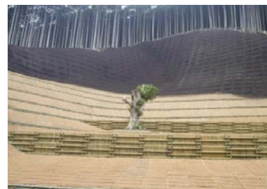
【山腹工に施工した丸太組土留工】
