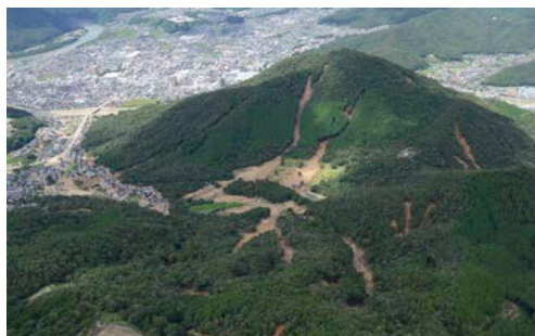
【高松山国有林の被災状況(遠景)】
