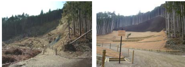
【和歌山県 紀伊田辺地区民有林直轄治山事業】 （補正予算により早期に完成した菖蒲谷山腹工）
