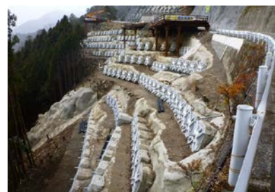
【奈良県 十津川地区民有林直轄治山事業 (堂平山腹工 アンカー工施工状況)】
