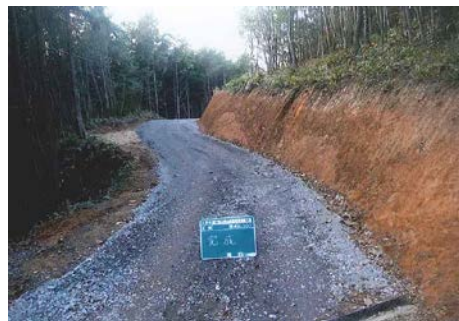
【第二新元重山林業専用道】(広島北部署(広島県神石高原町) 【平成26年度治山・林道工事コンクール 林野庁長官賞】
