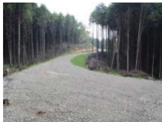
【林業専用道 第二野路山 （広島県呉市）】
