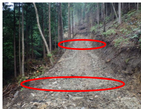
【森林作業道】 ～路面排水処理の状況～
