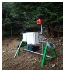
【土石流センサー設置状況】
