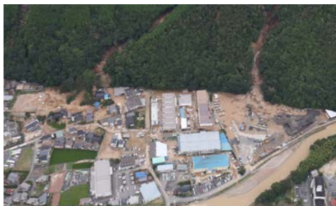
【高松山国有林の被災状況】
