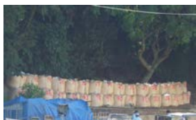
【大型土のうの設置状況】
