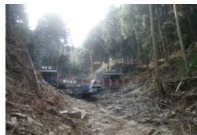
【強靱ワイヤーネット工施工状況】
