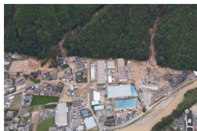
【高松山国有林の被災状況(近景)】
