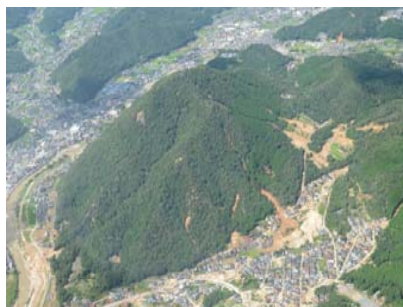
【高松山国有林の被災状況(遠景)】
