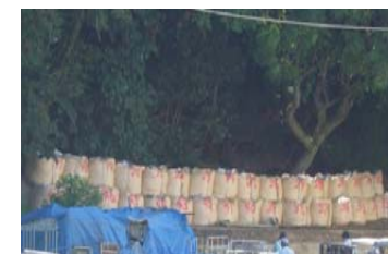
【大型土のうの設置状況】
