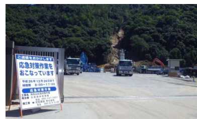
【流出土砂の撤去・運搬状況】
