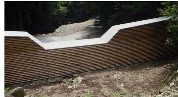
【コンクリート型枠に間伐材を使用
