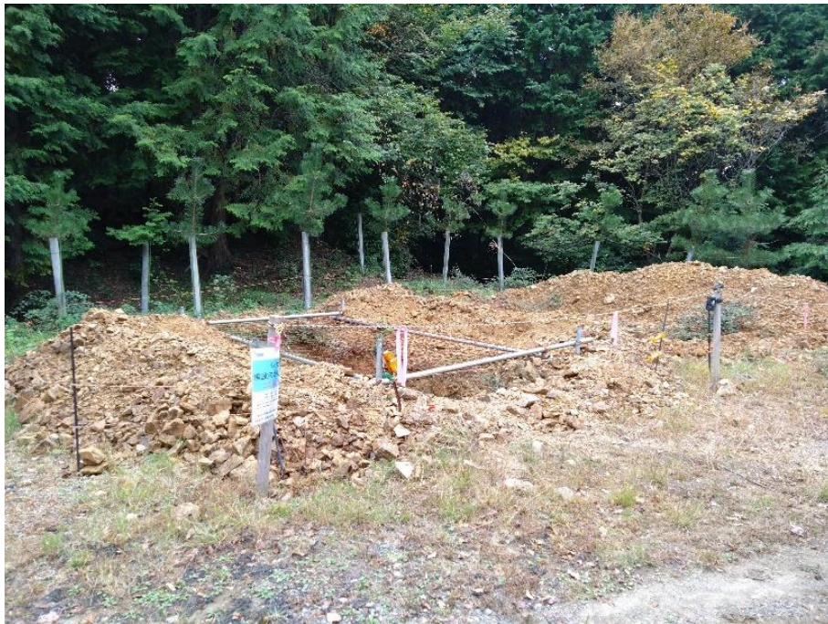
写真 2 - 3 埋設穴のクマ対策等の状況
