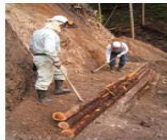
⑦ 土砂埋め戻し
