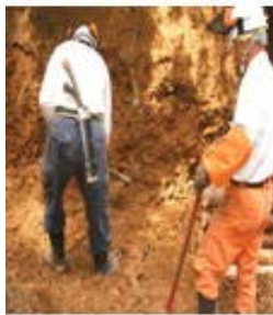
① 掘削整地
