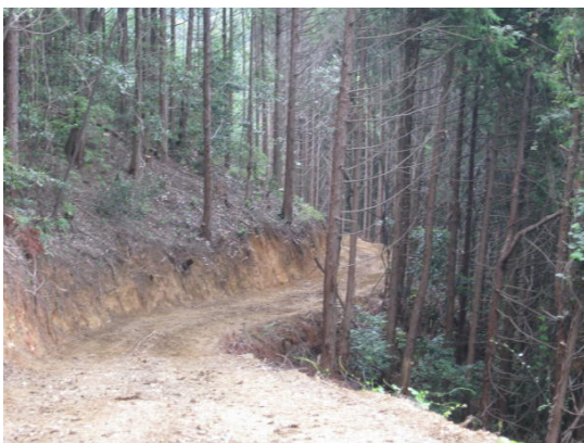
「森林共同施業団地(柿木山国有林)」 (島根県浜田市)
