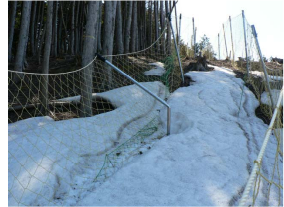
積雪によりシカ柵の支柱の折損状況
