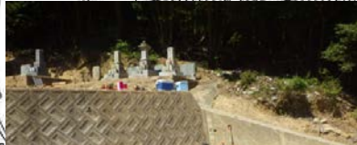
土砂整理後の状況
