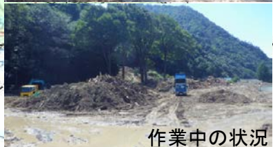
作業中の状況
