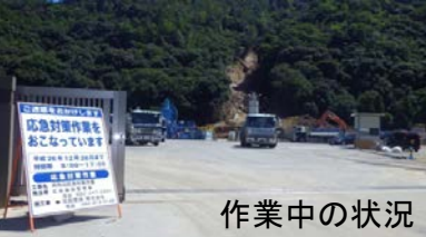
作業中の状況
