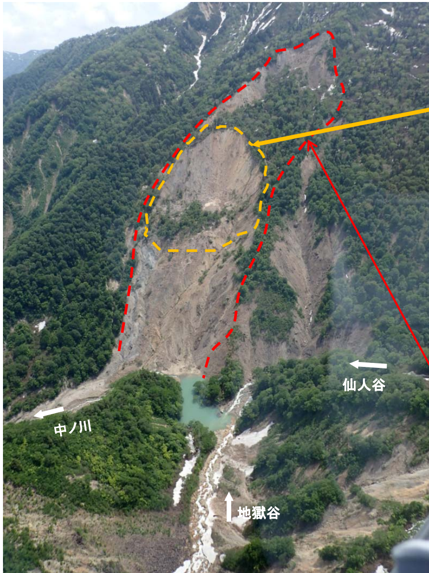
崩壊地正面の状況
