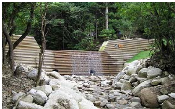
(景観を配慮しダム工に間伐材を利用しています。)
