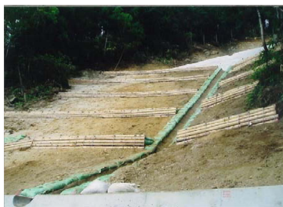
【間伐材を利用した山腹工】
