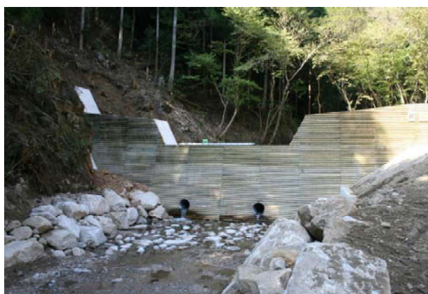
【間伐材を利用した谷止工】
