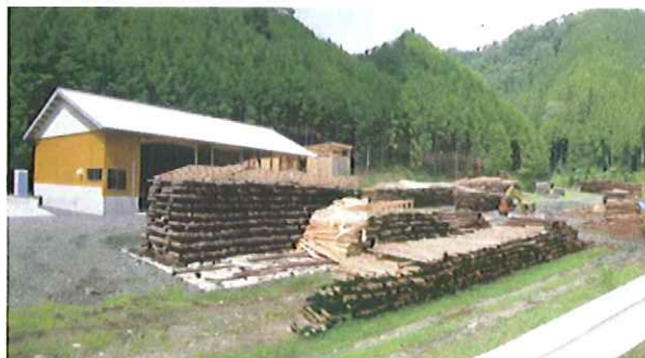
(木質バイオマス加工施設(チップ製造工場・資材置場)の様子)
