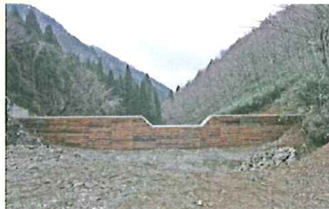
(岡山署：木製型枠を利用した谷止工)
