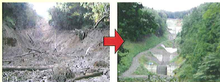
（福井県一ツ谷川上流地区での復旧の様子）
