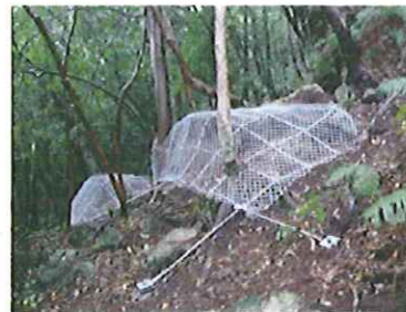
（ワイヤーネット伏工の様子）
