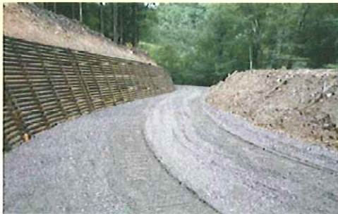
(兵庫署：林道法面への丸太積工)
