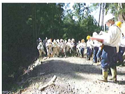
（丸太組アンカーによる補強の様子）
