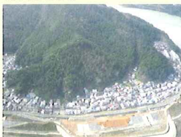
（民家と隣接する国有林の空中写真）
