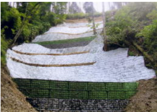
山腹斜面の復旧
