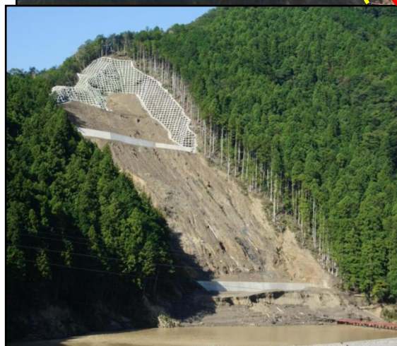
NO.1、NO.2土留工 完成状況
