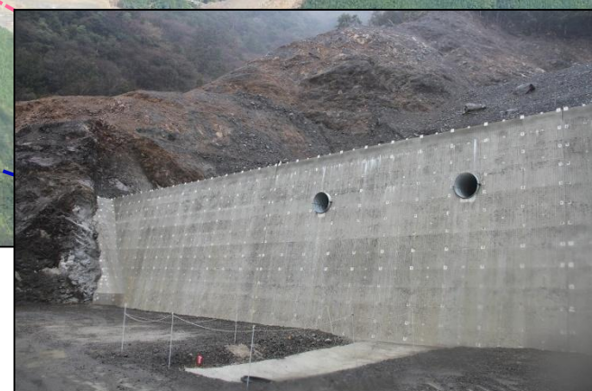
第2期谷止工事 完成状況
