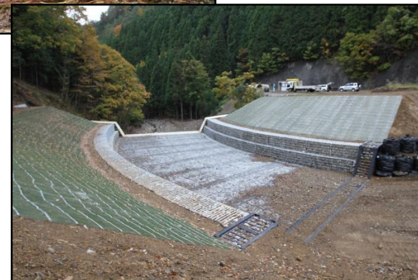
流路工 完成状況
