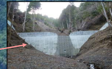
第5号谷止工完成状況
