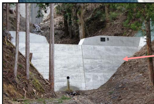
4号谷止工 施工状況
