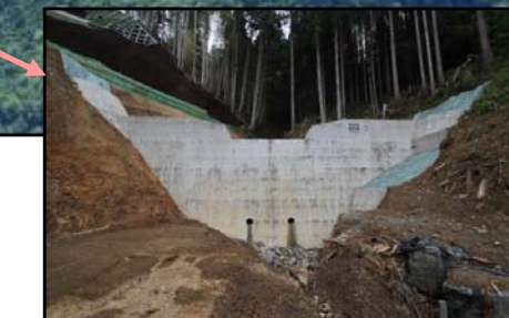
第1号谷止工 完成状況
