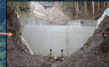
第2号谷止工 完成状況
