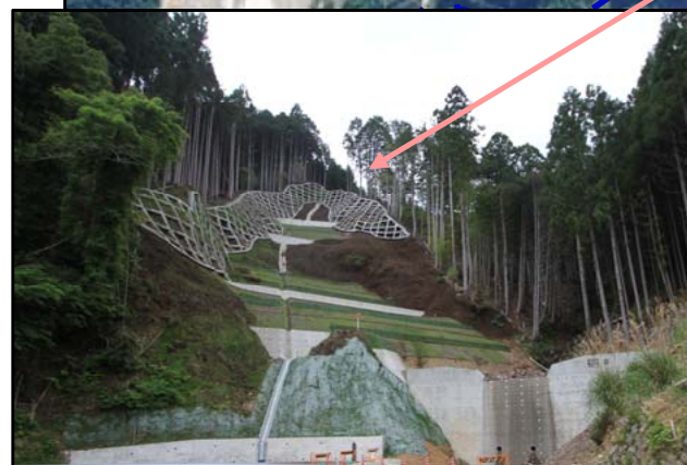
山腹工 完成状況
