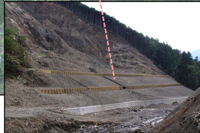
木製土留工 完成状況
