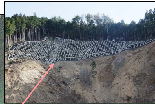
法砕工 完成状況
