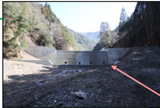
第2号谷止工 完成状況
