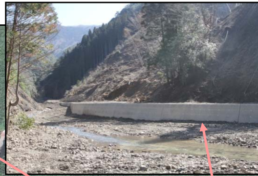
護岸工 完成状況
